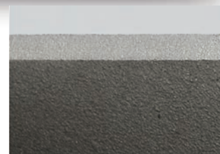
Parede Traseira Reforçada
